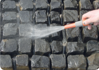
Reinigung der Fläche
