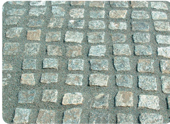
Fertig verfugte Fläche
