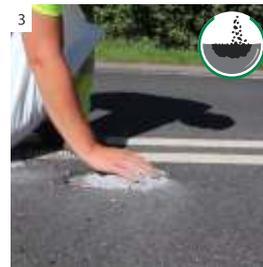
3 Füllen Sie eine Schicht Sinco BituChip von maximal 15mm in den Einsatzbereich
