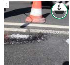
4 Erhitzen Sie das Material auf ca. 200°C mit dem Gasbrenner.
